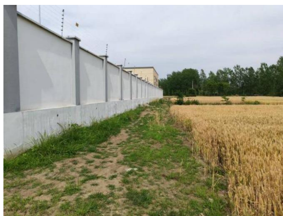
升压站南边界绿化情况
