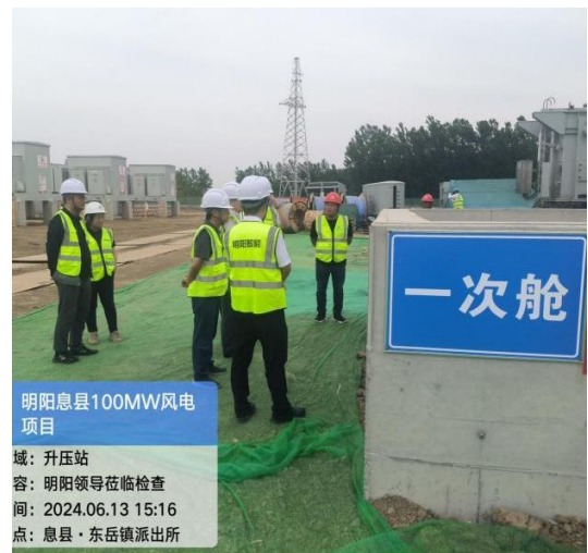
施工期场地覆盖
