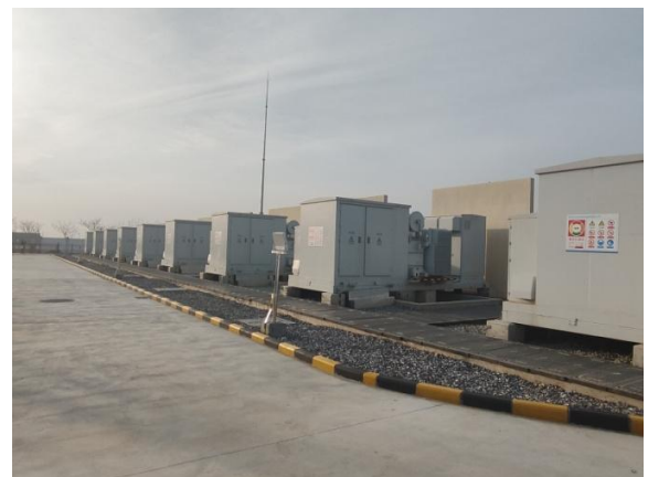
升压站内硬化
