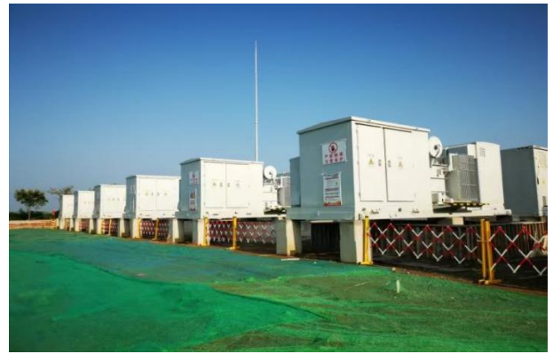
施工期临时土方覆盖②
