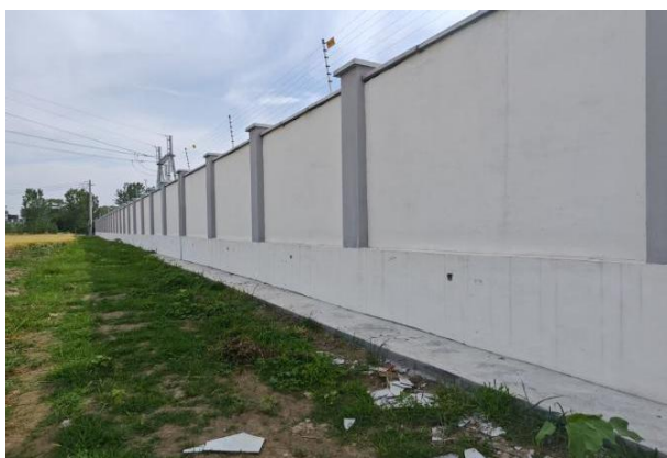
升压站东边界绿化情况
