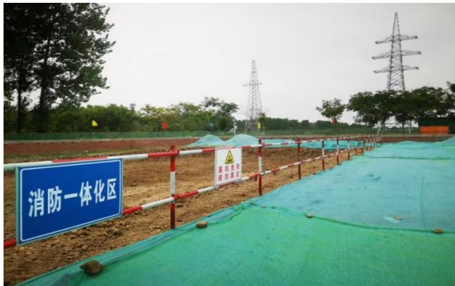
施工期临时土方覆盖①
